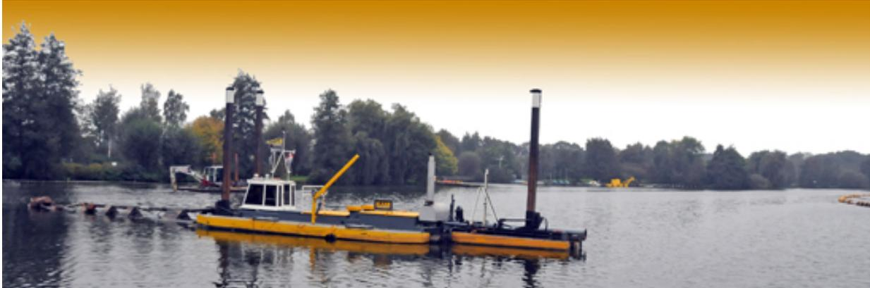
**Borken/Hoxfeld.** Was lange währt, wird endlich gut! Kilometerlange Rohrleitungen sind verlegt, die Spülbecken hinter der Mülldeponie sind fertig, der Schwimm-Bagger schwimmt, der Saugbagger wartet auf den Anschluss und dann kann es endlich losgehen: Raus mit dem alten Schlamm und Morast aus den Untiefen des Pröbstingsees, damit die Tretbootfahrer, Segler, Angler, Fische und last but not least die Paddler wieder den See in allen Belangen genießen können.
